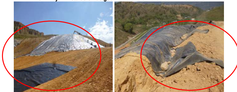
IMAGEN 1 y 2: Instalación de geomembrana en la Celda N° 2 Cárcava 2
