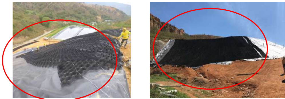
IMAGEN 3 y 4: Instalación del Neoweb en la Celda N° 2 Cárcava 2
