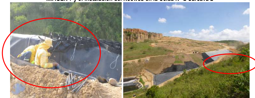
IMAGEN 9 y 10: Esparcimiento de la capa orgánica sobre el Neoweb en la Celda N° 2 Cárcava 2
