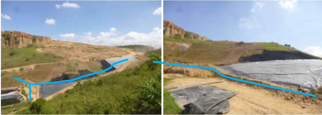
IMAGEN 1 a 4: Inicio de instalacion de capa de control de infiltración.
