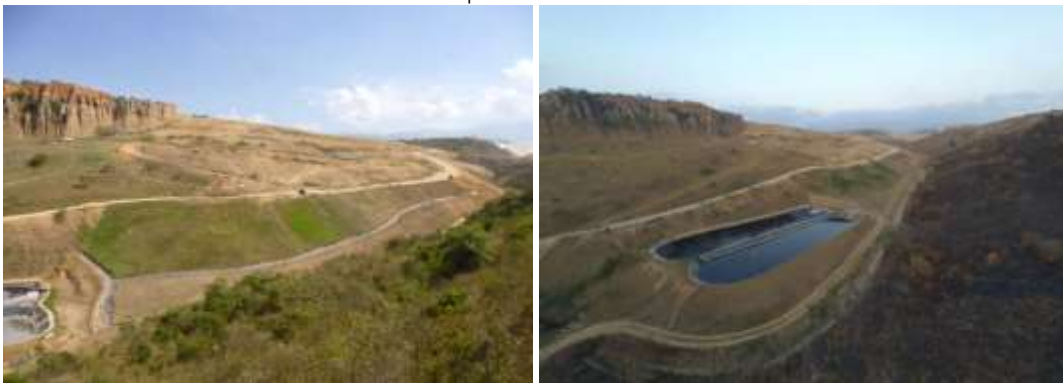
IMAGEN 1 a 4: Finalización de la instalacion de la capa de control de infiltración.
