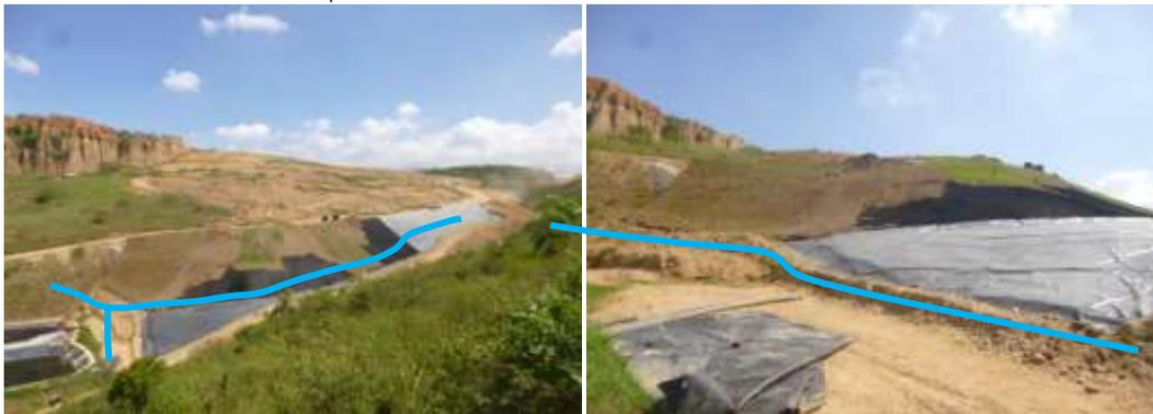
**IMAGEN 1 a 4:** Finalización de la instalación de la capa de control de infiltración.
