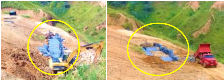
IMAGEN: Construcción de llave estabilizadora.
