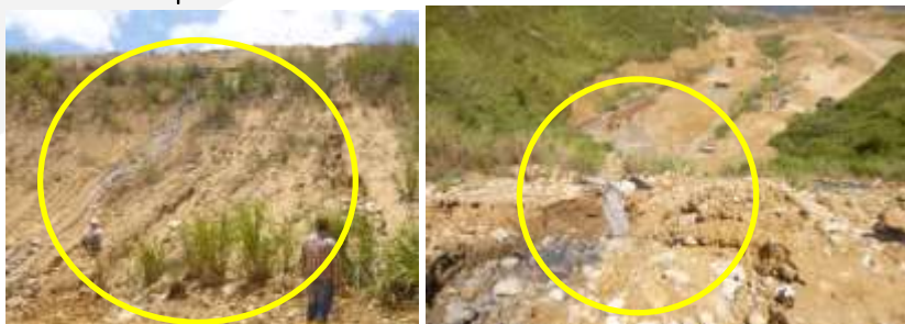
IMAGEN: Formación de surcos en el dique.
