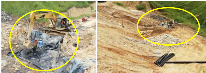
IMAGEN. Obras de control llave estabilizadora.
