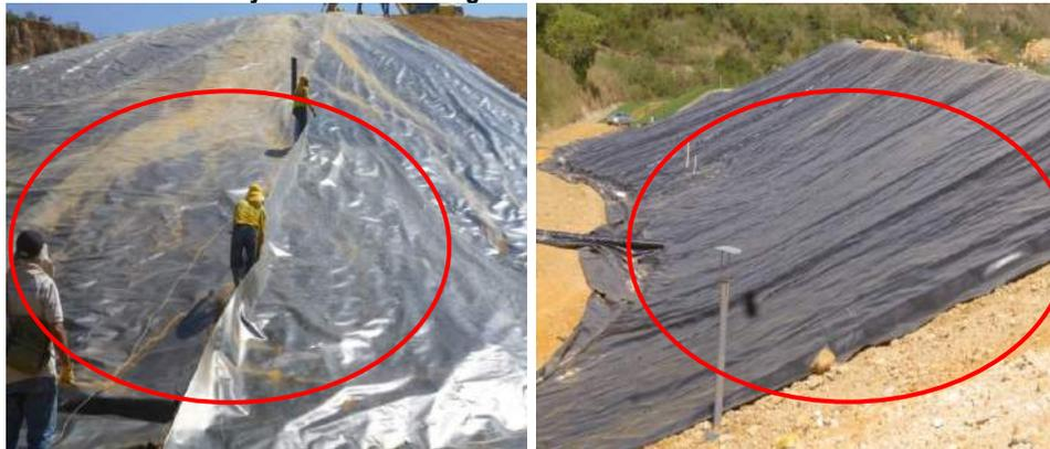
**IMAGEN 7 y 8: Instalación del Neoweb en la Celda N° 2 Cárcava 2**
