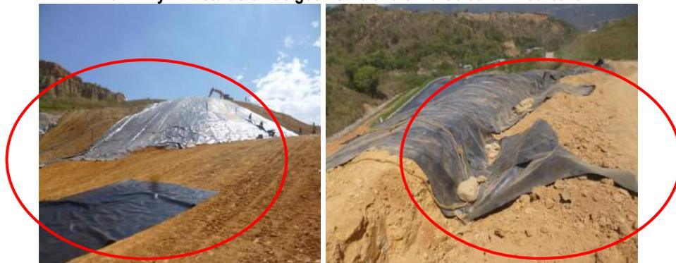
**IMAGEN 3 y 4: Instalación del Neoweb en la Celda N° 2 Cárcava 2**
