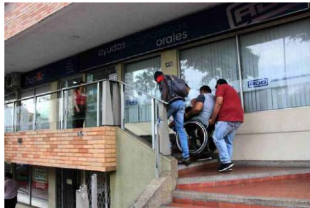
FIGURA 41. EDIFICIO SIN SOLUCIÓN DE ACCESIBILIDAD A PREDIO
