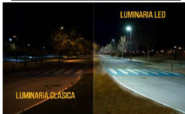
FIGURA 74. LUMINARIA CLÁSICA VS LUMINARIA LED
