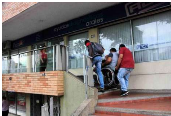
FIGURA 46. EDIFICIO SIN SOLUCIÓN DE ACCESIBILIDAD A PREDIO
