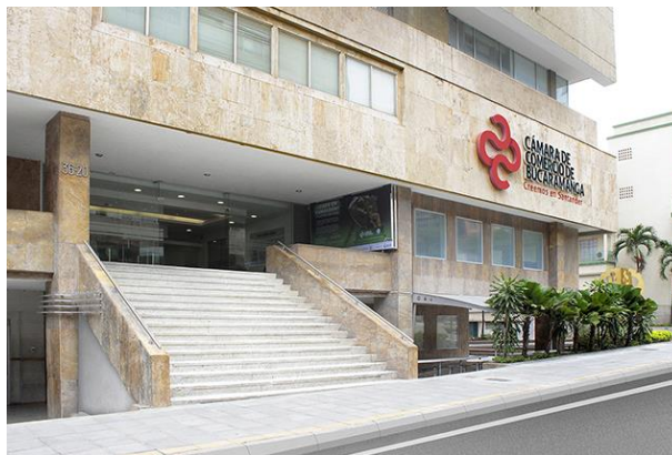
FIGURA 46. EDIFICIO SIN SOLUCIÓN DE ACCESIBILIDAD A PREDIO
