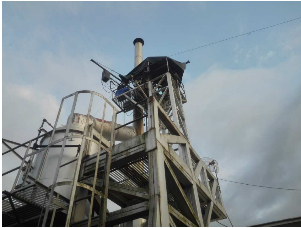
Foto 1. Montaje Equipos En chimenea
