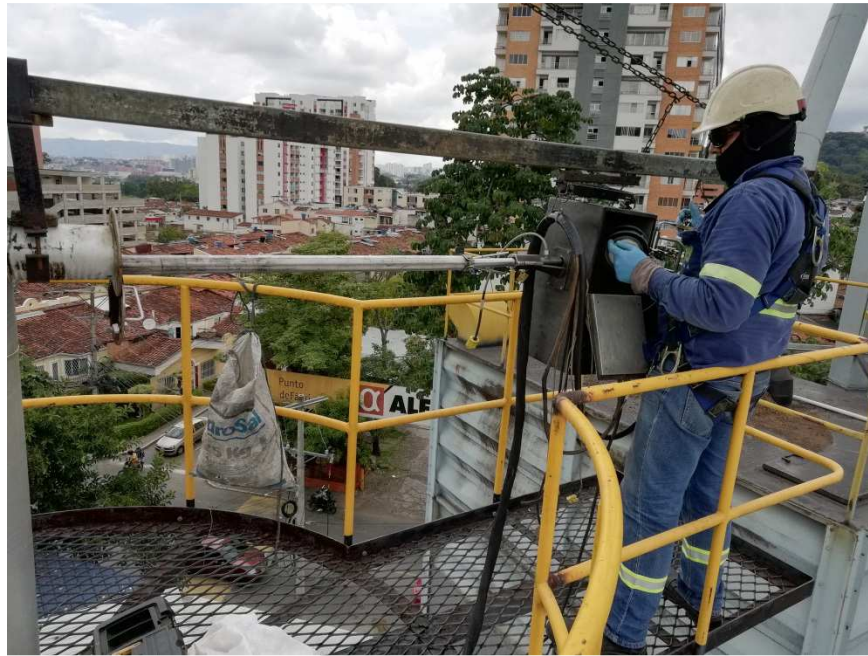
Foto 1. Montaje Equipos En chimenea
