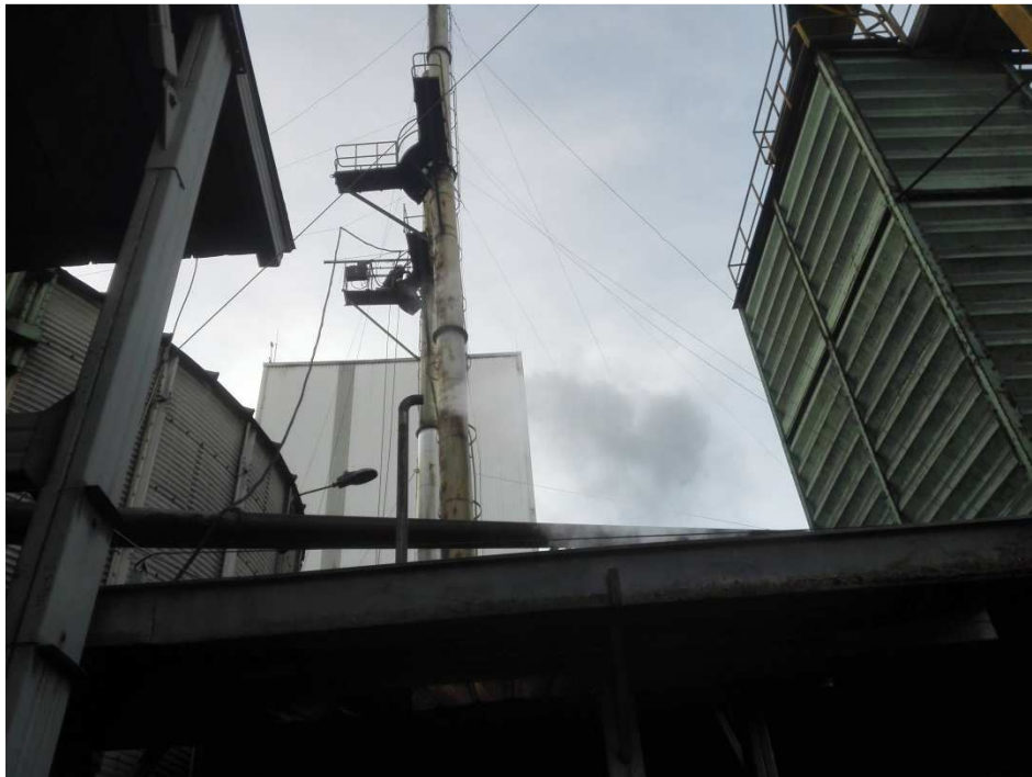
Foto 2. Vista General de la Fuente
