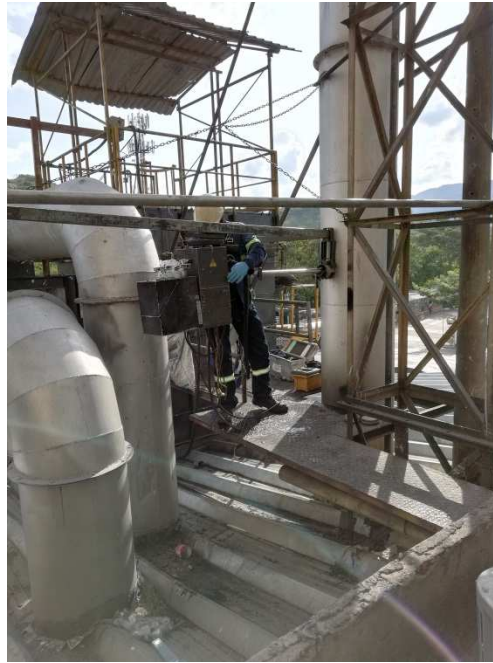
Foto 1. Montaje Equipos En chimenea
