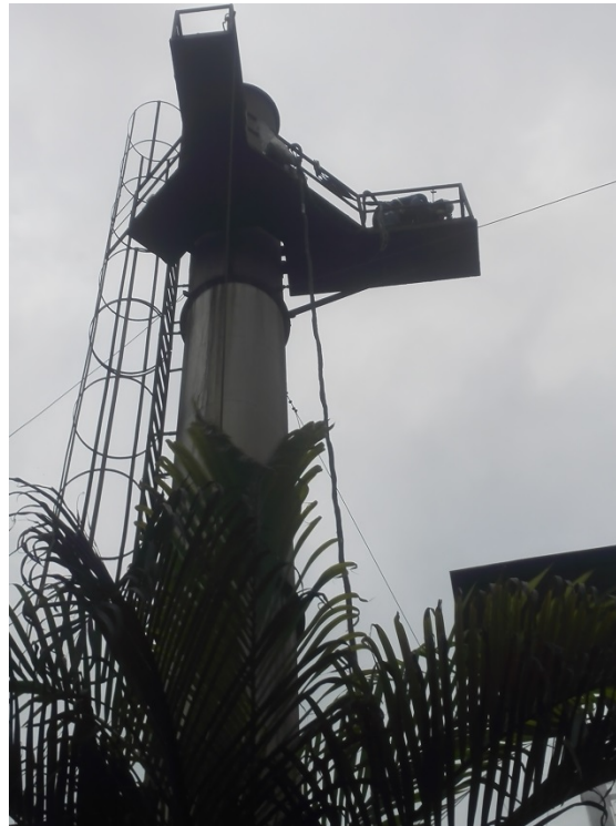
Foto 1. Montaje Equipos En chimenea
