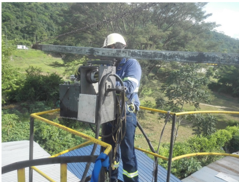
Foto 2. Montaje Tren de Muestreo
