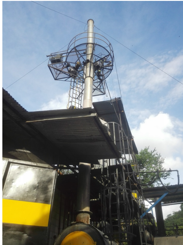
Foto 1. Vista General de la Fuente
