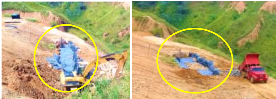
IMAGEN: Construcción de llave estabilizadora.
