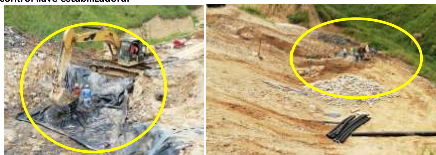
IMAGEN. Obras de control llave estabilizadora.
