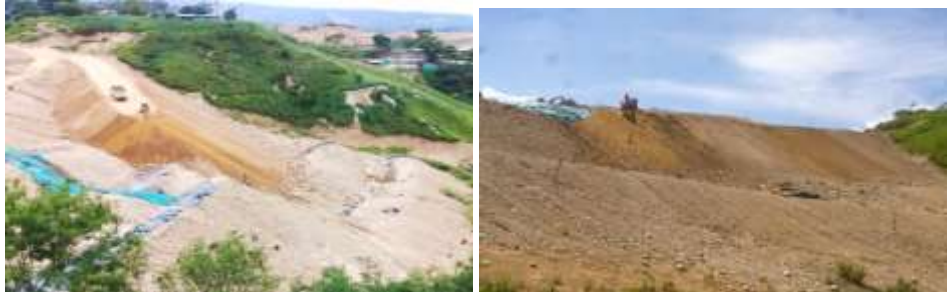
IMAGEN. Construcción de estructuras de contención y confinamiento
