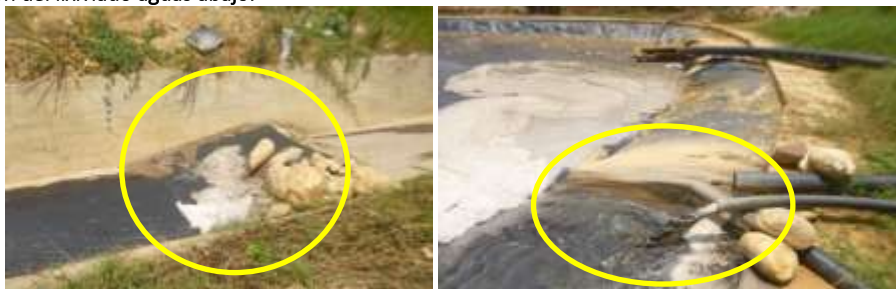
IMAGEN: Captación del lixiviado aguas abajo.
