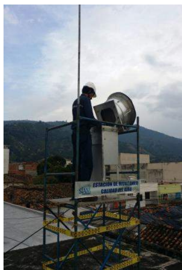
Imagen 1. Estación Calle 10 Con Carrera 9 Piedecuesta
