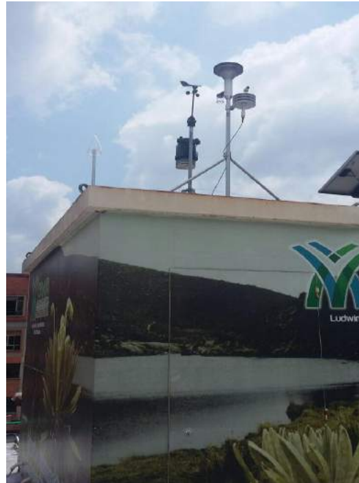
Estación de cabecera – cra 33 con calle 52
