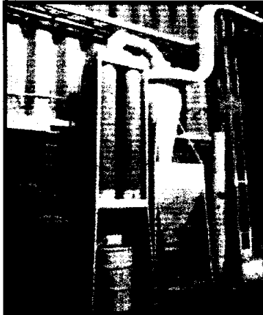
Foto 9. Filtro Dúo de Mangas
